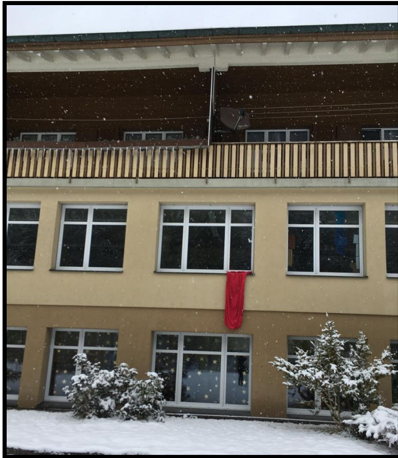
Schulhaus Fritzenhaus, Wasen iE
